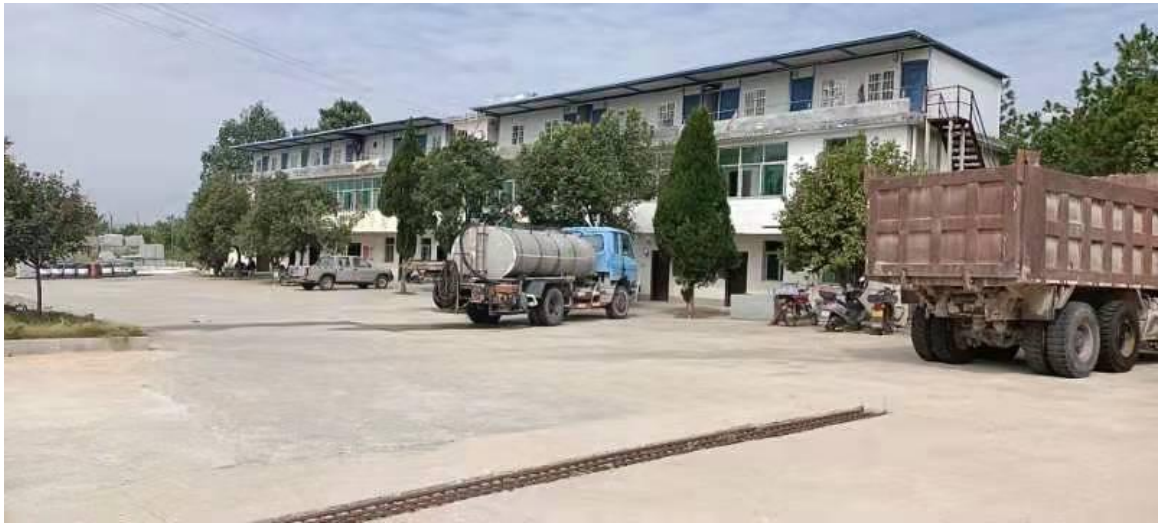
办公、宿舍(硬化路面)
