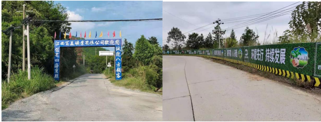
照 5-3 矿区未铺设沥青前水泥道路
