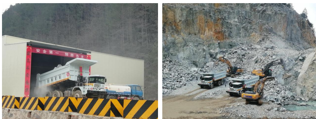
照 5-8 开采区生产区粉尘排放
