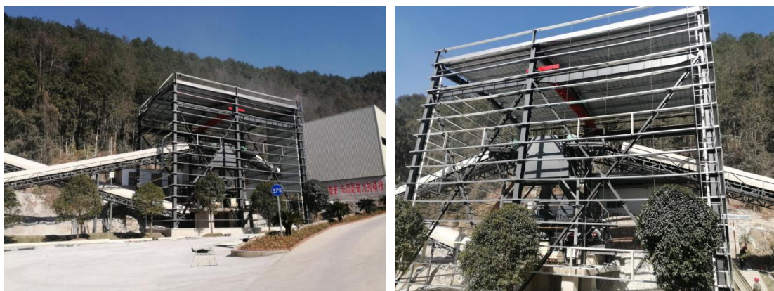
照 5-5 未全封闭的生产加工区
