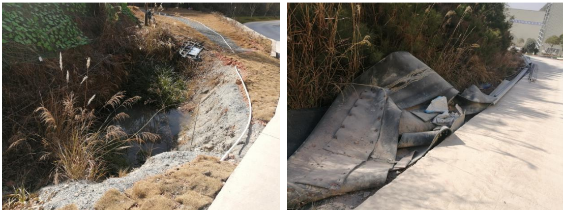
照 5-1 办公区生产区环境卫生情况
